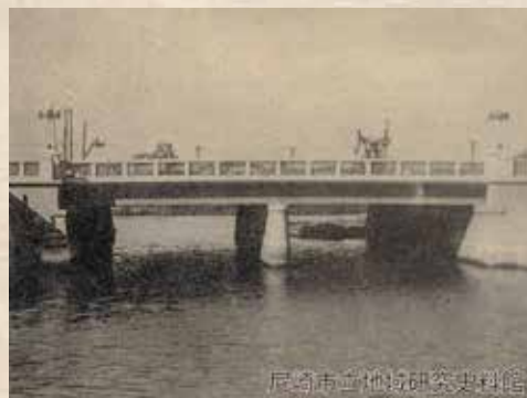
完成当時の稲川橋(長十四間四分、幅十五間)
