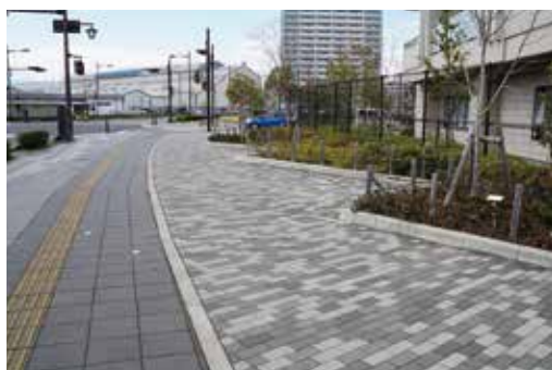
公園と歩道を一体整備
