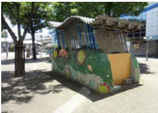
地下自転車駐輪場の出入口
