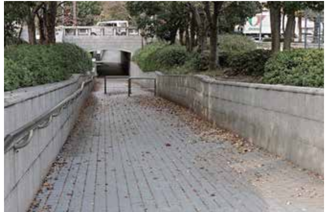
国道2号線地下通路
