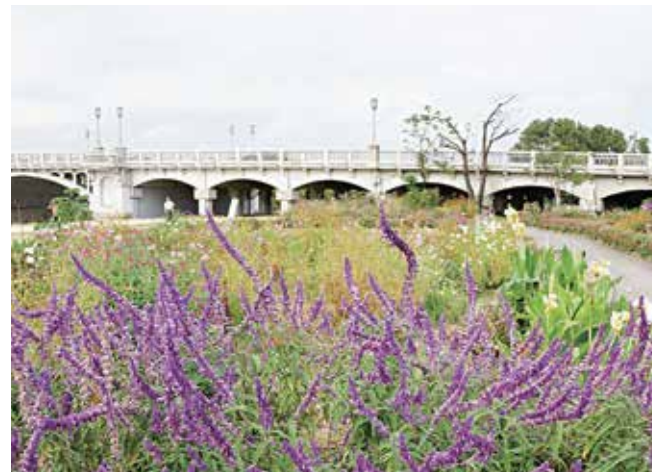
国道2号線武庫大橋
