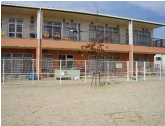
保育所との境界フェンス
