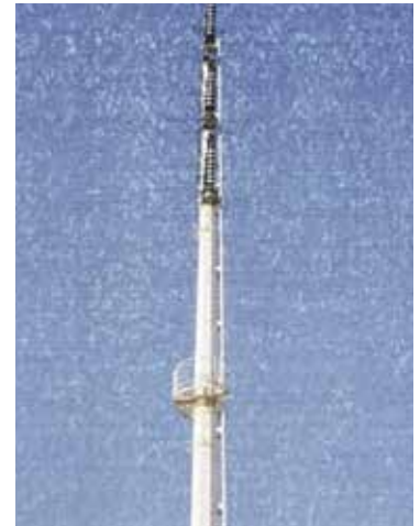
占用物件の関電鉄塔
