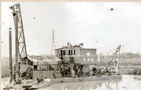
センタープール用地の浚渫・埋立工事 昭和27年頃
