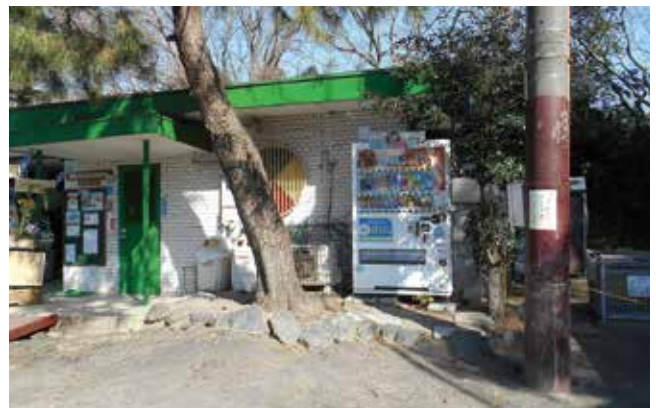
管理棟・自動販売機
